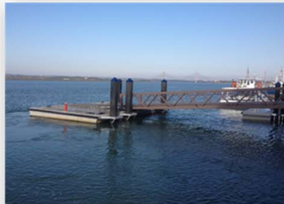
Pontona para vehículos con el Puente Internacional al fondo
