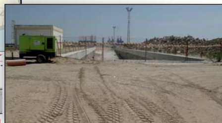
Vista general del estado actual de la rampa
