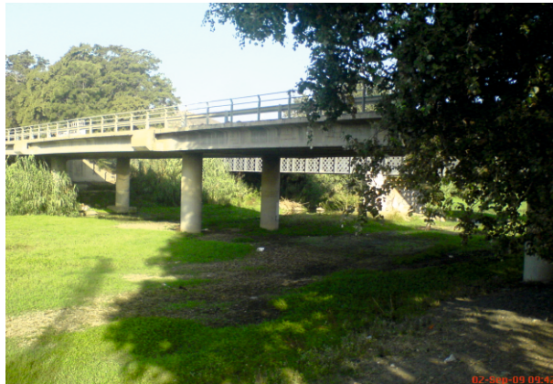
PUENTE DE LA CARRETERA N-340a
